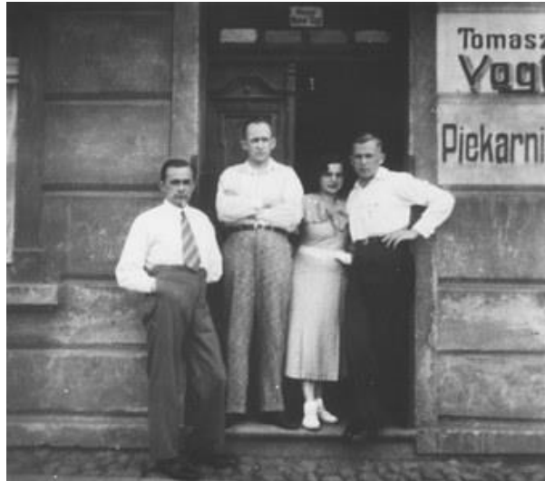
4 - Rodzina Vogtów przed sklepem
